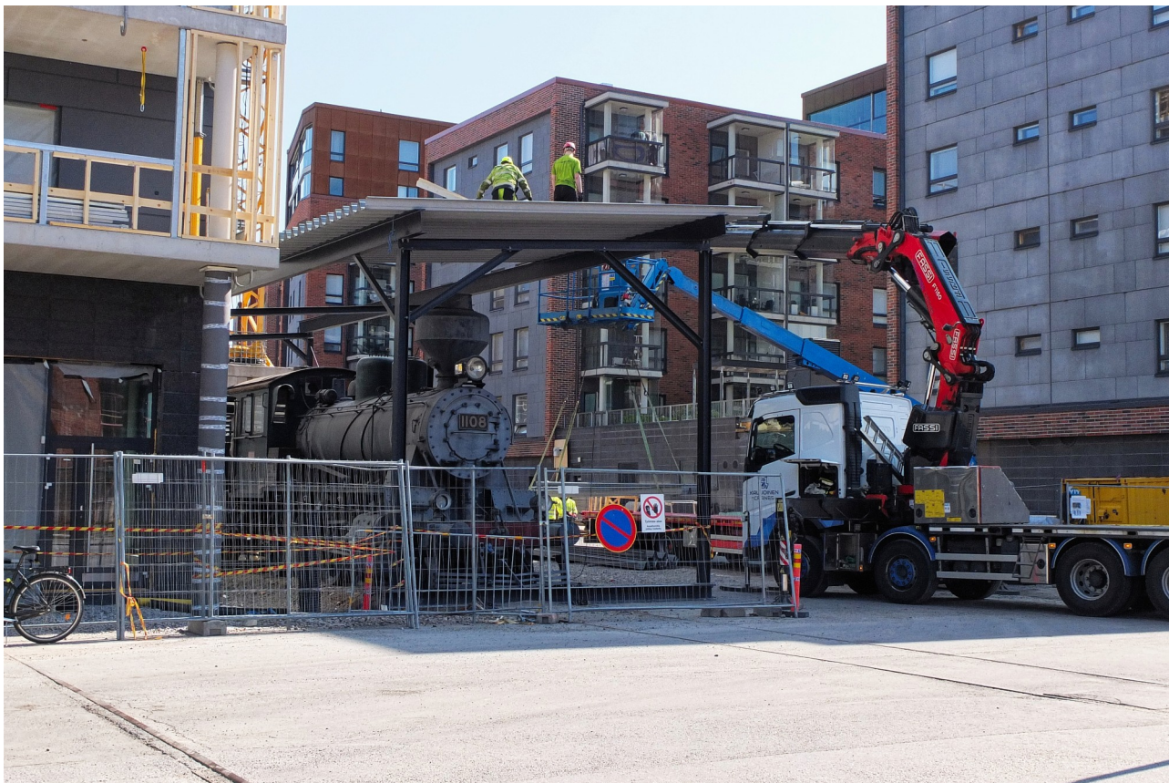
Katoksen purku käynnissä. Katolla Lasse Tauriainen ja Robin Raita. 27.5.2023 Kuva: Olli Savela
